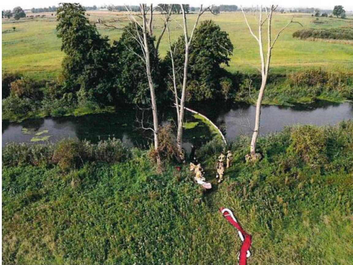
Zapora sorpcyjna na rzece Nępcz, mająca na celu ograniczenie skutków awarii.
